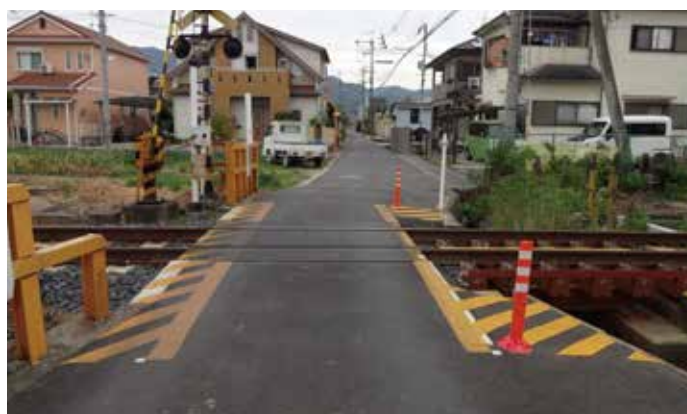
▲狭い踏切道の一例「尺土第6号」
